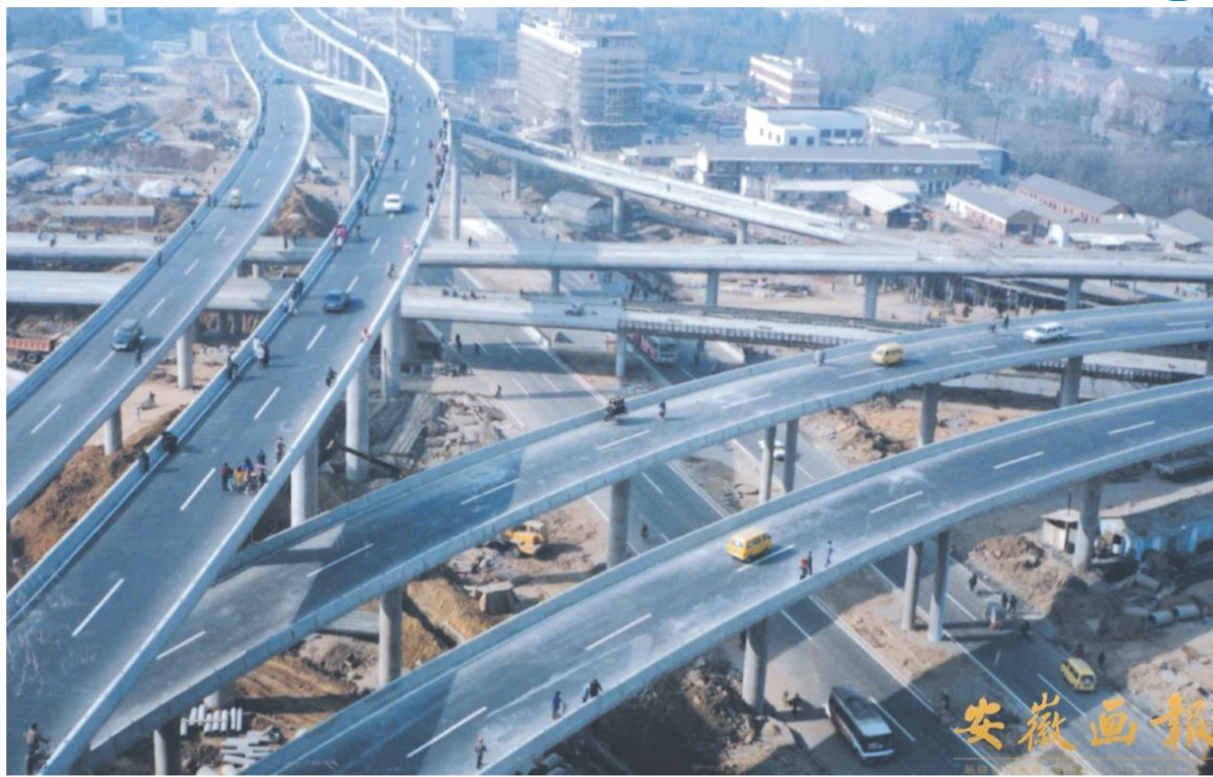
正在建设中的五里墩立交桥
