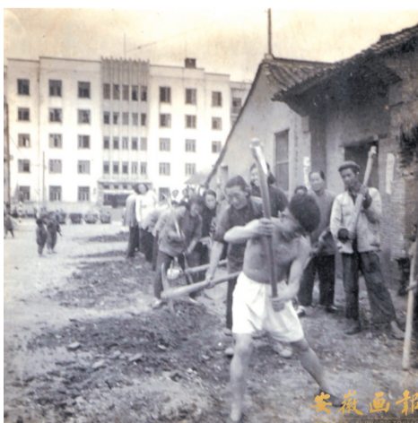
1958年，合肥长江饭店对面的桐城路改造成灰灰大道现场
