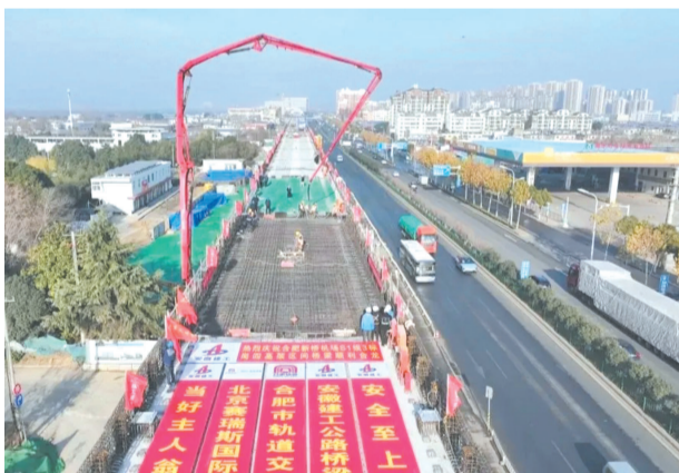
S1线岗集站至四里河站高架区间桥梁合龙现场
