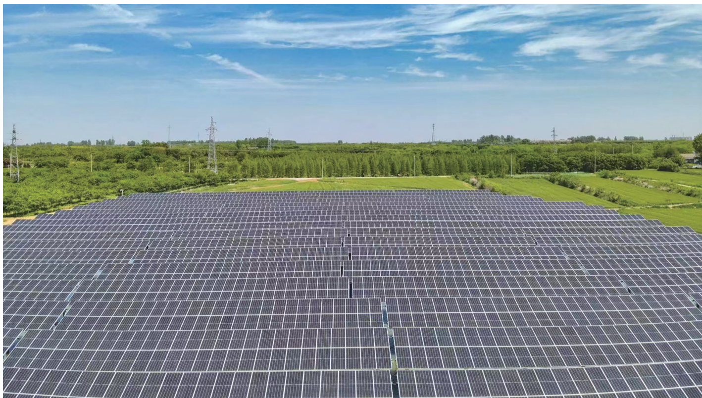
肥东县八斗镇渔光互补光伏发电项目
