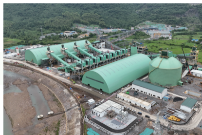
中建材年产 4000 万吨骨料项目建设现场。韩亚东/摄
