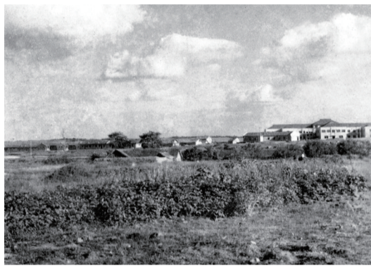
刚刚建设的安徽医学院
