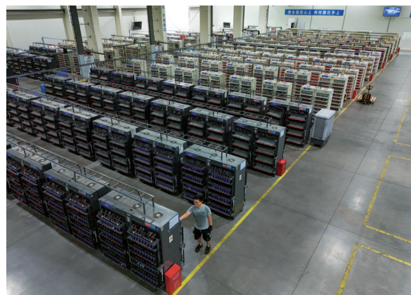
安徽巡鹰新能源集团新能源电池回收再利用车间
