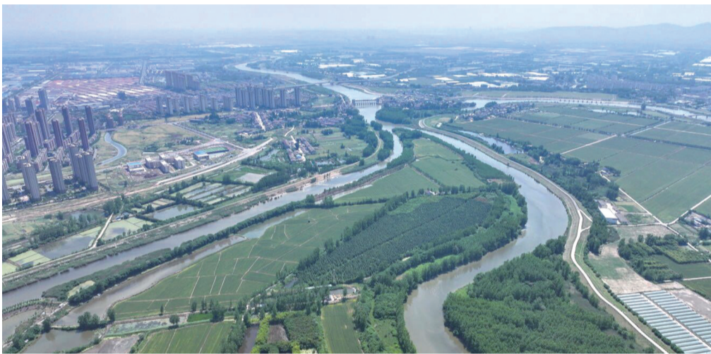
五四圩台区是江苏被滁河“分割”在安徽一侧的“飞地”。左侧为安徽,右侧为江苏,中间部分为五四圩台区。
