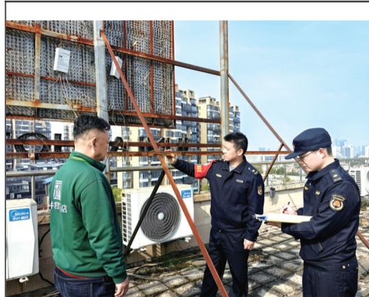
为规范户外广告招牌设置,及时消除安全隐患。3月26日,合肥高新区城管执法大队联合兴园中心城管中队,对望江西路沿线的招牌设施开展安全生产检查工作,对检查中发现存在钢架变形、焊接点松动、固定件脱落、画面破损等安全隐患问题,第一时间责令当事人整改、维护、拆除,进一步确保人民群众“头顶上的安全”。
