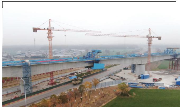
11月26日,中铁上海工程局参建的淮宿蚌城际铁路跨宿州西外环(60+2×100+60)m连续梁经过2小时连续浇筑,顺利合龙。据了解,新建淮北至宿州至蚌埠城际铁路位于安徽省北部,线路起自淮萧联络线淮北站,经郑徐高铁衔接徐州枢纽,中联规划皖北城际亳州至蚌埠段、淮北至阜阳段,南端引入蚌埠地区与京沪、合蚌高铁及规划宁滁蚌城际铁路衔接。该铁路是皖北地区城际铁路网和京沪高铁辅助城际通道的重要组成部分。项目建成后将进一步优化区域铁路网布局,加强皖北城市群与合肥都市圈交通联系,促进沿线经济与社会发展。
