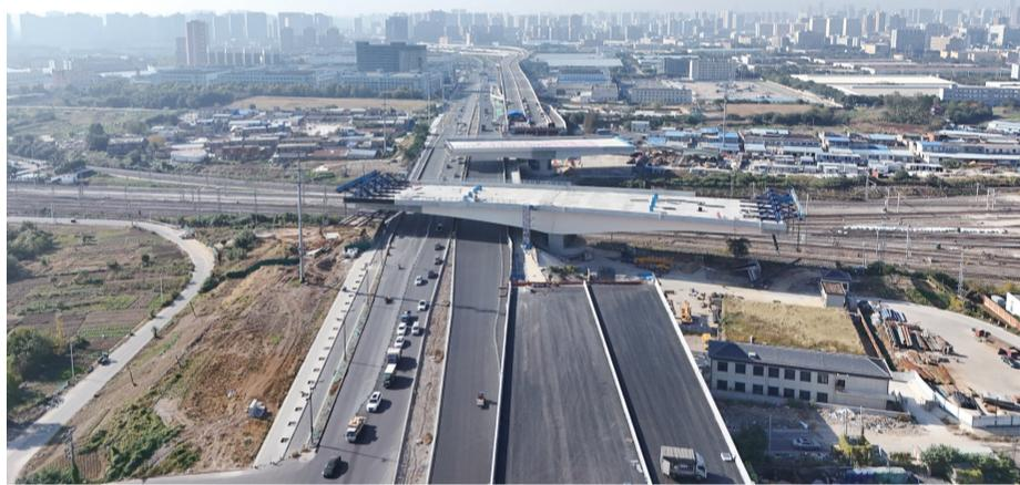
星报讯(刘燕燕 记者 王珊珊/文 周诚图) 11月1日上午9时40分,随着施工现场总指挥一声令下,一座重1.3万吨的转体桥在牵引设备作用下,开始逆时针缓缓转动85度到达指定位置,实现精准就位,标志着贯通合肥市南北大动脉的文忠路(郎溪路-少荃街)工程向年内建成通车目标迈出了关键性一步。
