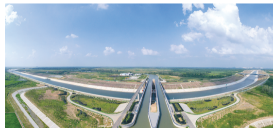
江淮沟通段重点工程淠河横渡槽
