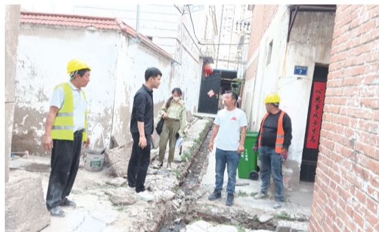
筛子市17巷小区路面施工改造现场
