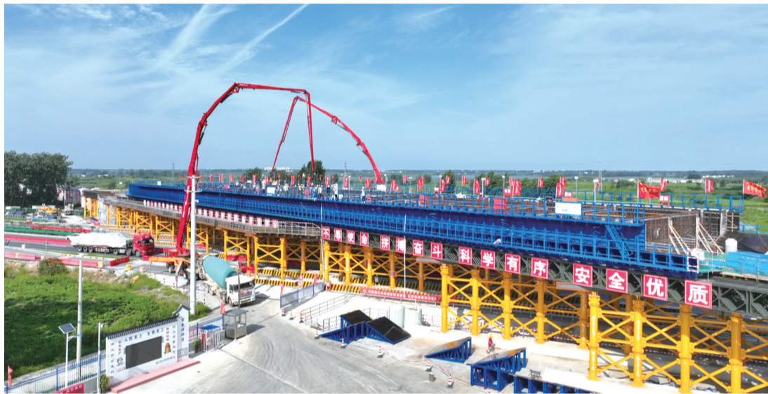
定远2号特大桥连续梁第一节浇筑现场。 陈小光/摄
