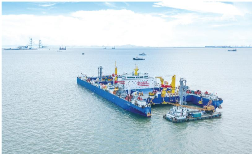
“一航津安1”号沉管运输安装一体船在沉放安装E23管节和最终接头,背后是建设中的深中通道伶仃洋大桥(6月9日摄,无人机照片)。
