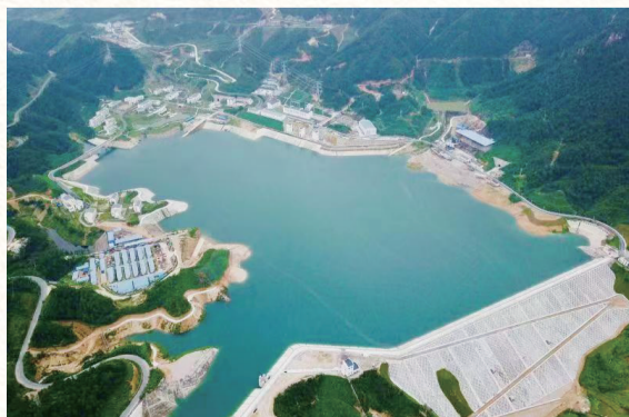
绩溪县抽水蓄能电站
