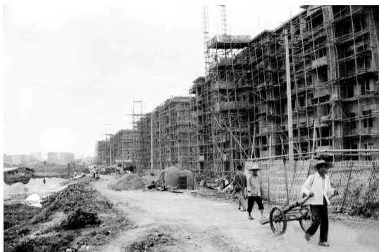
第一次改造前的长江路
