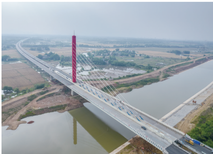
合枞高速孔城河特大桥
