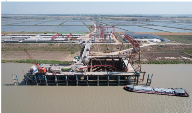
星报讯(记者 祝亮 文/图) 5月31日,在滔滔淮水间,一座高6米、面积近900平方米的建筑物完成浇筑。这座建筑是安徽省“县城通”高速项目之一——合(肥)周(口)高速寿(县)颍(上)段淮河特大桥的主墩承台,标志着淮河特大桥进入主体施工阶段。
