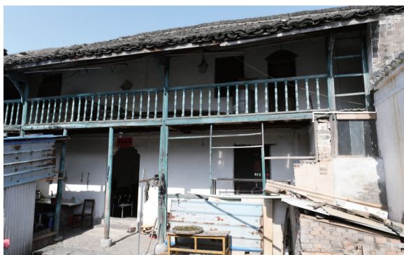
胡家瓦屋旧址
