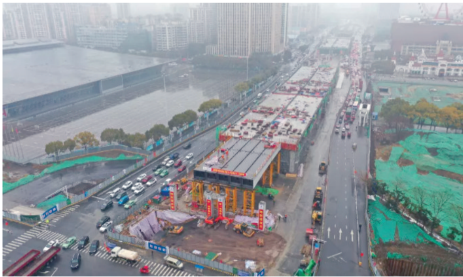
金寨路高架南延工程施工现场
