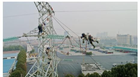
1月17日,在合肥市蓬莱路附近,电力工人们正在抓紧时间进行220千伏大学城变电站110千伏送出线路工程的建设工作。春节前,合肥供电公司将按时投运2个大型变电站、3个线路工程,新增约580兆伏安的电力容量,保障广大市民度过火红新春佳节。 ■李岩
