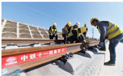
12月1日，在湖南省长沙市望城区常益长高铁黄桥大道特大桥施工现场，中铁十一局施工人员将一对500米长的无缝钢轨精准铺设在无砟轨道板上，标志着常益长高铁建设开始进入关键的轨道铺设阶段。常益长高铁全长约157公里，设计时速350公里，是国家“八纵八横”高速铁路网的重要组成部分。■新华社记者 赵众志/摄
