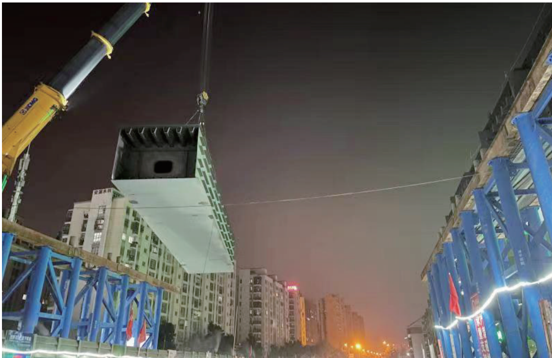
郎溪路跨新安江路钢箱梁主梁顺利合龙
