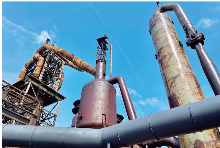
马(合)钢高炉区开始进行防腐除锈施工
