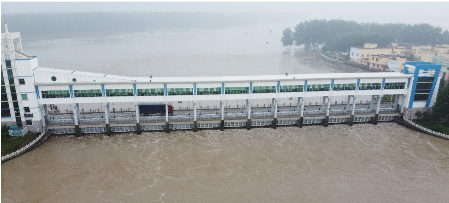
正在关闸的淮河王家坝闸
