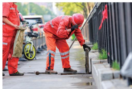
夏季是汛期高发季,为做好汛期各项保障工作,合肥市高新区城管局全面摸排辖区各污水管网堵塞情况,并结合各立交桥、道路低洼点、下穿桥的视频监控及液位监测系统,及时监测易涝点,确保园区各环节排水点畅通。图为工作人员正打开雨水篦子,检查管道内部堵塞情况。
