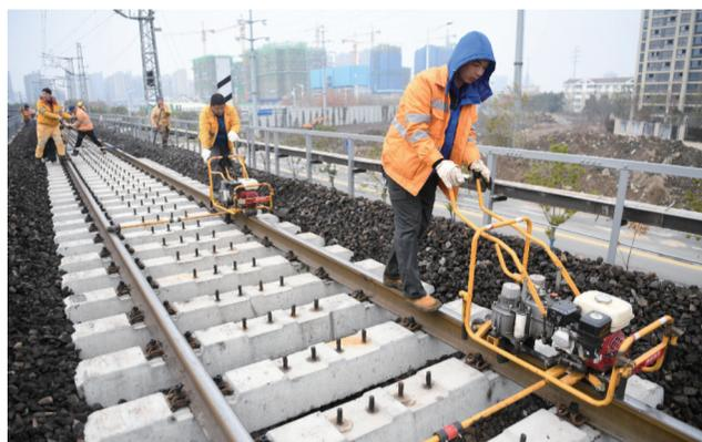
12月20日,施工人员在宁芜线上更换水泥枕。当日,由中国铁路上海局集团有限公司上海工务大修段等单位共同参与的7.7公里宁芜线水泥枕更换工程顺利完工,进一步提升了线路的安全性和稳定性,为即将到来的春运保驾护航。 □ 新华社发
