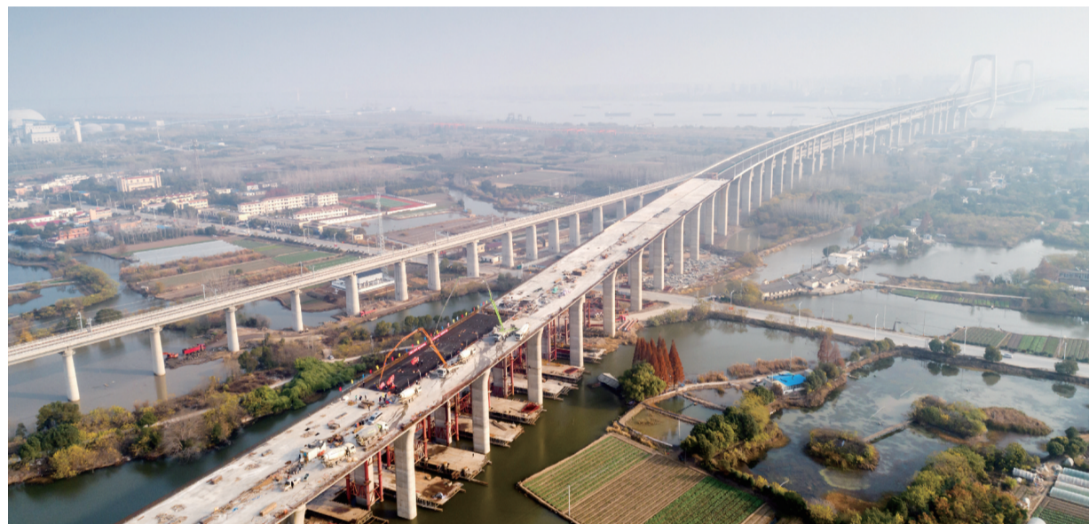
12月15日无人机拍摄的商合杭铁路芜湖长江公铁大桥公路接线工程江北接线桥浇筑施工现场。□新华社发
