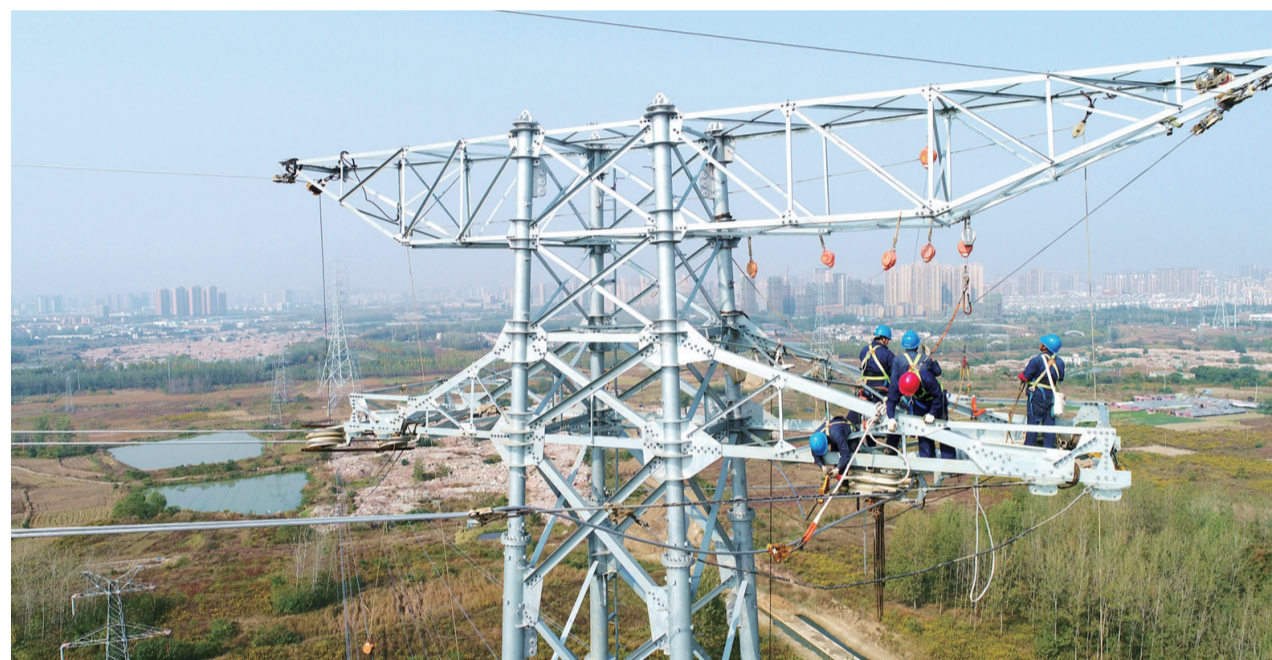
合肥市十大电网重点工程——东螺线建设现场
