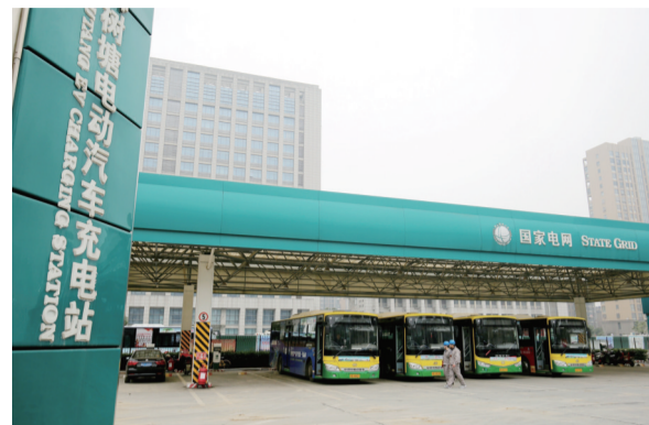
“十分钟”电动汽车充换电网基本形成
