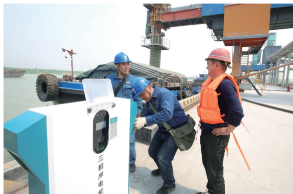
合肥供电公司员工协助港口船主进行接电服务
