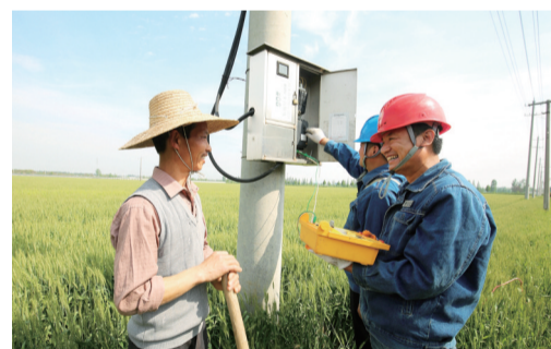
4月20日,安徽合肥供电公司同大供电所员工上门服务农民,确保春耕用电平稳。(李岩)
