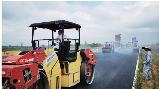
祥和路摊铺沥青现场
