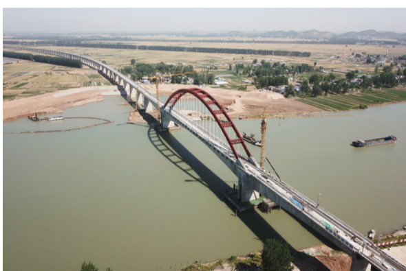
商合杭高铁跨淮河特大桥开始铺轨
