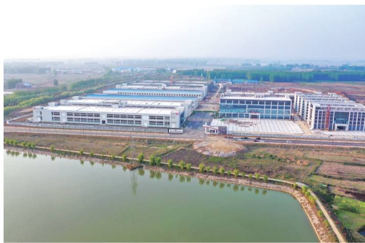
正在建设和生产中的盼盼食品厂
