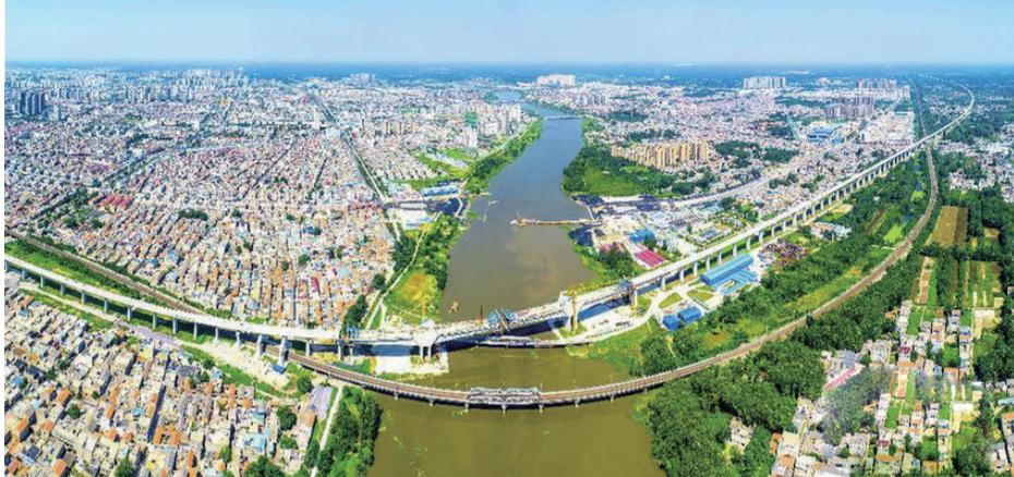
商合杭高铁安徽亳州段正在加紧施工建设中,商合杭高铁(商丘—合肥—杭州)是国家八纵八横高速铁路网的重要组成部分,线路全长794.55公里,设计时速350公里。图为航拍的位于安徽省亳州市的商合杭高铁跨涡河特大桥。
