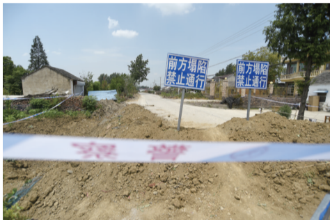
现场拉起警戒线,发生塌陷的区域禁入
