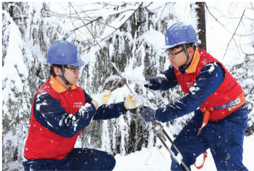
滁州市供电公司员工抢修供电设备
