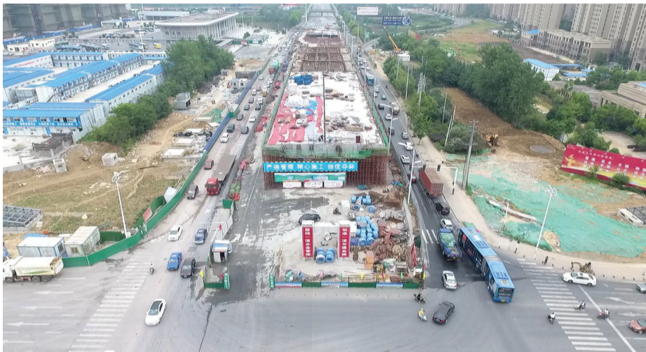
创新大道工程施工现场
