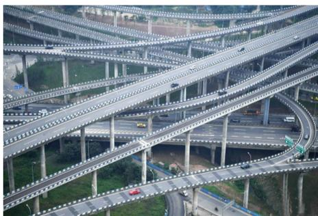
5月31日,不少车辆穿梭在已经完工的重庆黄桷湾立交桥上。据悉,黄桷湾立交桥有五层结构、15条匝道向8个方向延伸而去,被誉为“重庆主城最复杂立交”。
