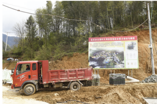
大湾扶贫移民安置点正在紧张施工
