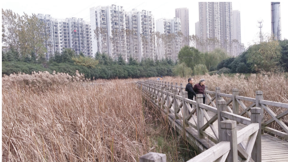
引桥南段现状
