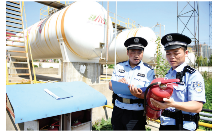
▲在燃气公司进行消防设施检查
