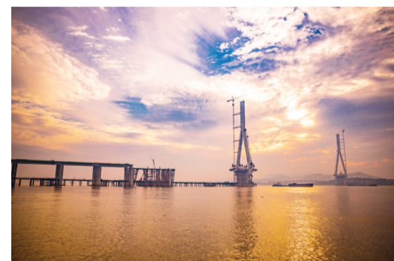
建设中的望东长江大桥
