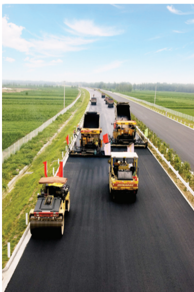
高速公路施工
