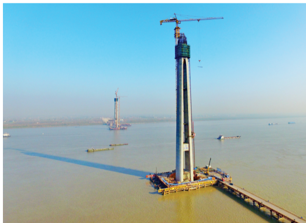
芜湖长江公路二桥主塔施工
