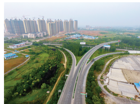
双墩高速出入口
