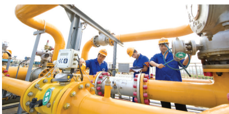
管道维护 保障供气
