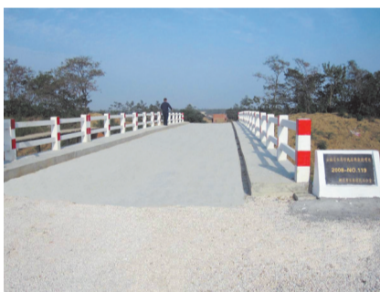
白龙镇墩稍村机耕桥施工后
