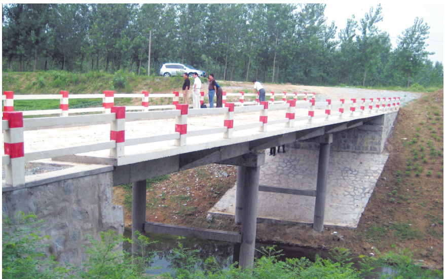
竣工的小吕机耕桥工程
