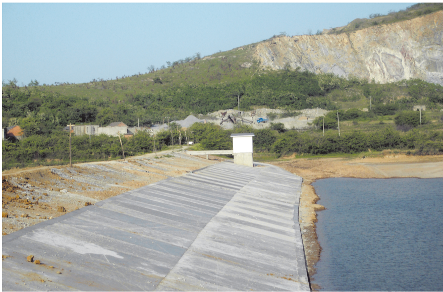
加固中的新坝水库
