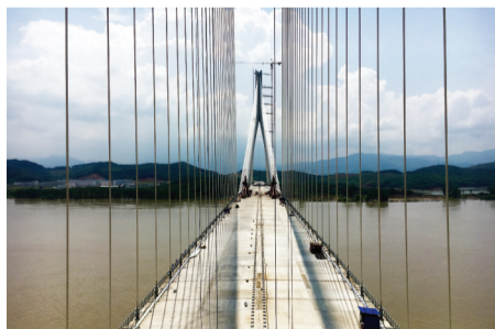
建设中的望东长江大桥
