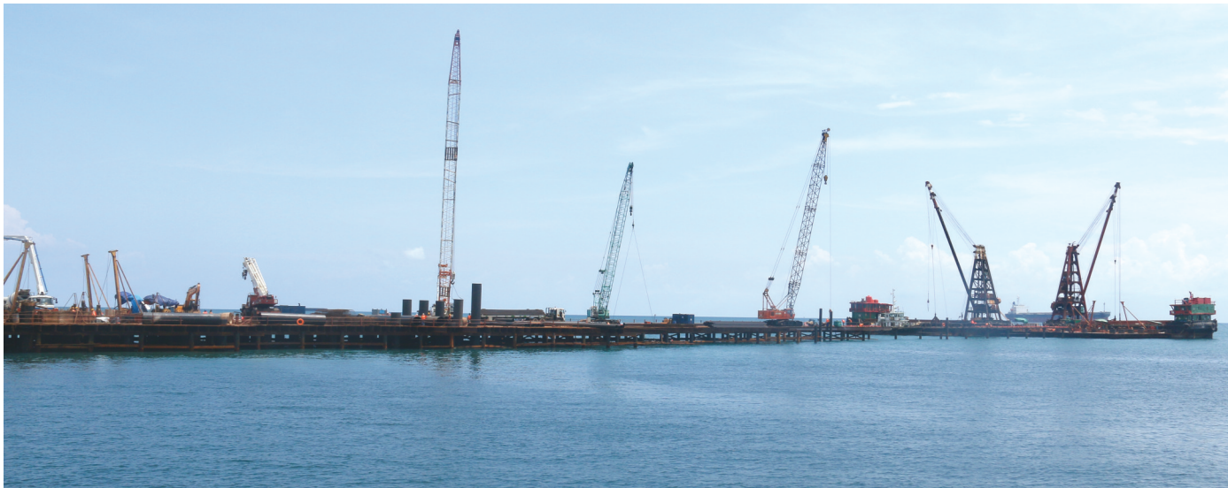
建设中的印尼海螺孔雀港码头
