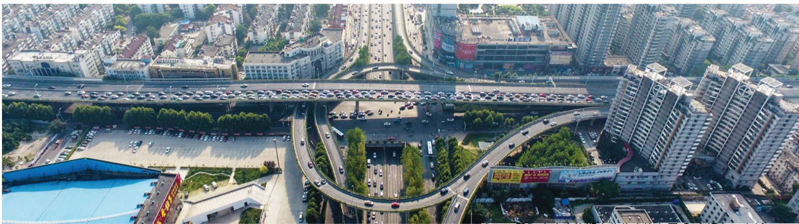
南一环马鞍山路高峰期由北往南堵车严重,车辆积压在桥面
