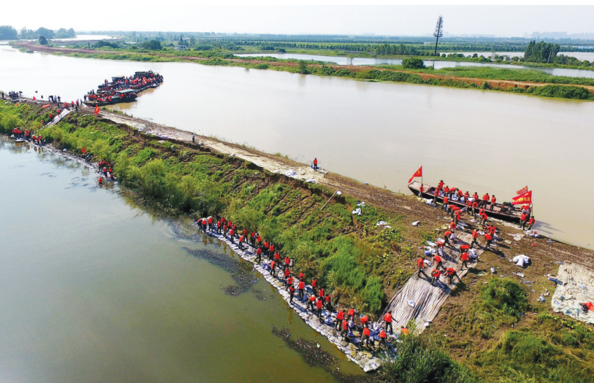
肥西下西圩抢险现场
