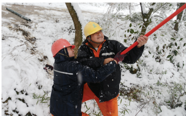
宣城供电部门职工雪中抢修线路。记者 曹开发/图
