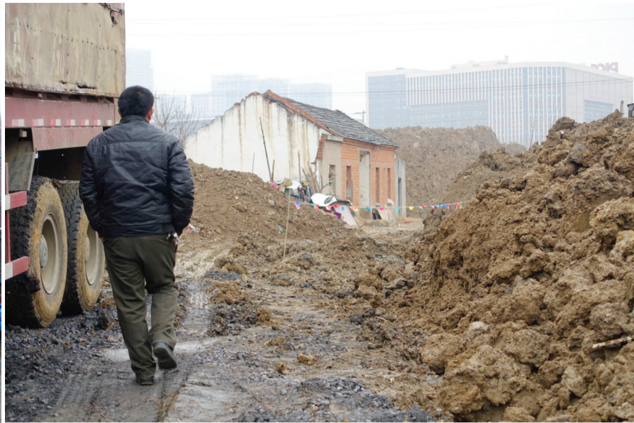
张书霞家横亘在道路中央,因道路施工周边成为工地
