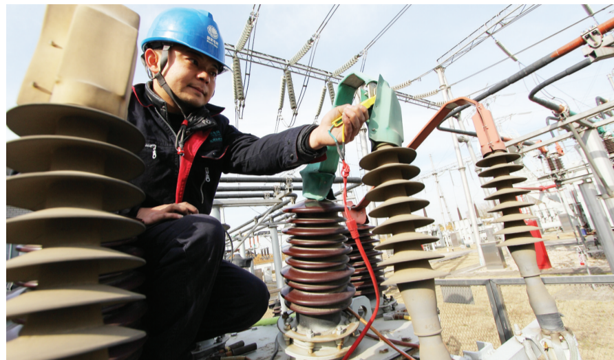
12月10日、12月16日,一周内合肥电网负荷两次打破冬季历史新高。为确保冬季电网大负荷情况下全市供电设备安全运行,合肥供电公司利用近期晴好天气,组织开展全市多个变电站集中检修工作,确保合肥电网健康运行,安全度冬。图为合肥供电公司工作人员对35千伏设备进行检修。 李岩 记者 李尚辉 文/图
